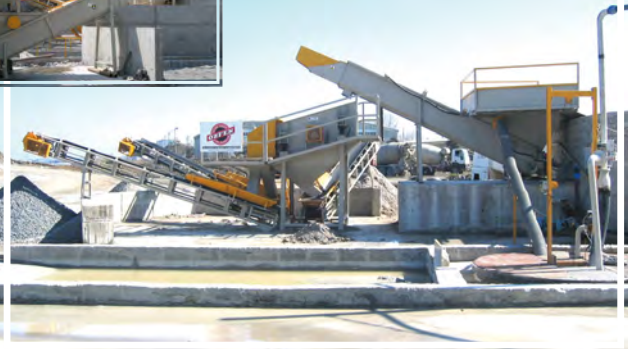
YAŞ BETON GERİ DÖNÜŞÜM TESİSİ
