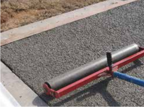
Şekil 10: Geçirimli beton kaplamanın yerleştirilmesi ve sıkıştırılması - 2
