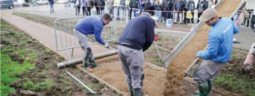
Şekil 9a: Geçirimli beton kaplamanın yerleştirilmesi ve sıkıştırılması - 1
