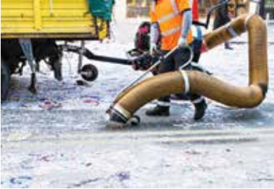
Şekil 13: Geçirimli beton kaplamaların vakumla temizlenmesi
