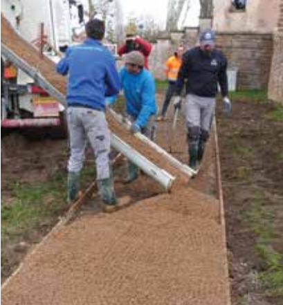
Şekil 9b: Geçirimli beton kaplamanın yerleştirilmesi ve sıkıştırılması - 1
