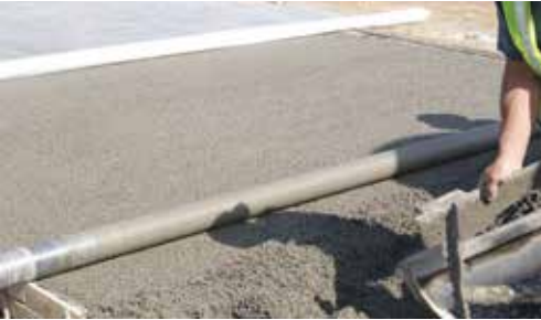
Şekil 12: Geçirimli betonun yüzey örtüsüyle kaplanarak kürlenmesi
