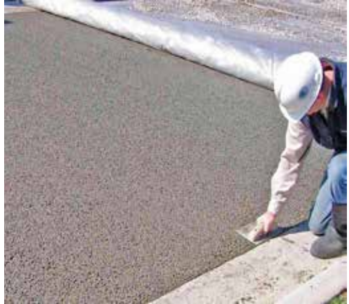
Şekil 9b: Geçirimli beton kaplamanın yerleştirilmesi ve sıkıştırılması - 1
