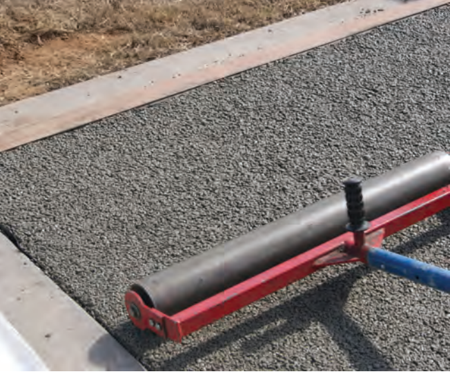
Şekil 10: Geçirimli beton kaplamanın yerleştirilmesi ve sıkıştırılması - 2
