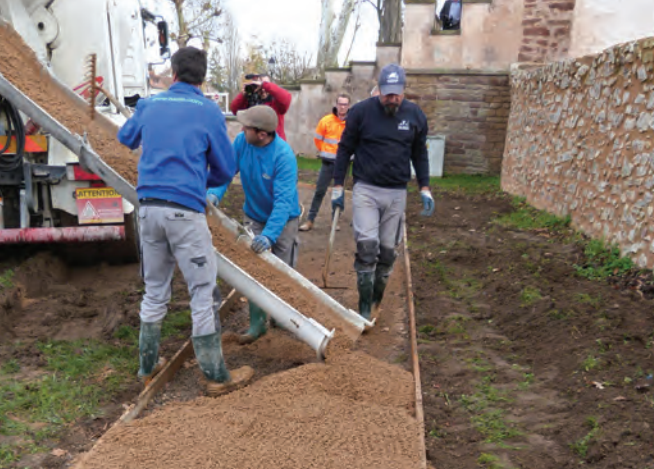
Şekil 9b: Geçirimli beton kaplamanın yerleştirilmesi ve sıkıştırılması - 1
