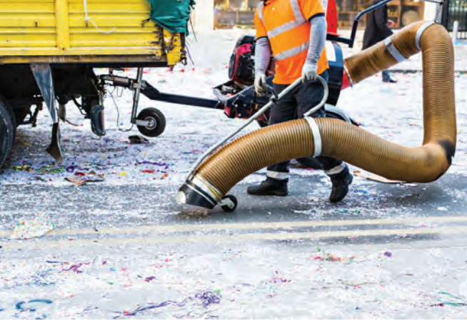
Şekil 13: Geçirimli beton kaplamaların vakumla temizlenmesi
