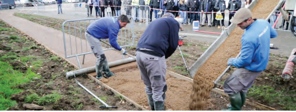
Şekil 9a: Geçirimli beton kaplamanın yerleştirilmesi ve sıkıştırılması - 1
