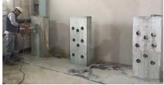
Şekil 3. Kolon Elemanlarından Karot Numunesi Alım İşlemi
