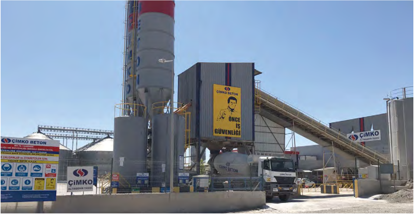
ÇİMKO Altıyenişir Hazır Beton Tesisi
