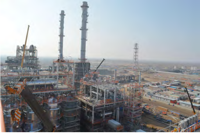
Doğalgazdan Benzin Üretim Tesisi Projesi, Aşkabat / RÖNESANS
