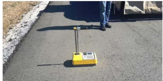
Şekil 13: Beton yoğunluğunun nükleer cihazla ölçümü
