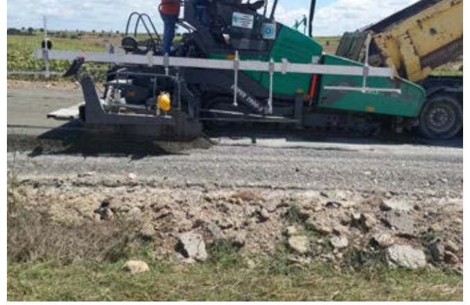
Şekil 3: Betonun kamyonun finişer önüne boşaltılması
