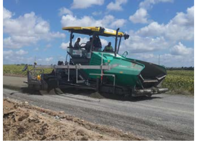
Şekil 4: SSB'nin yerleştirilmesi
