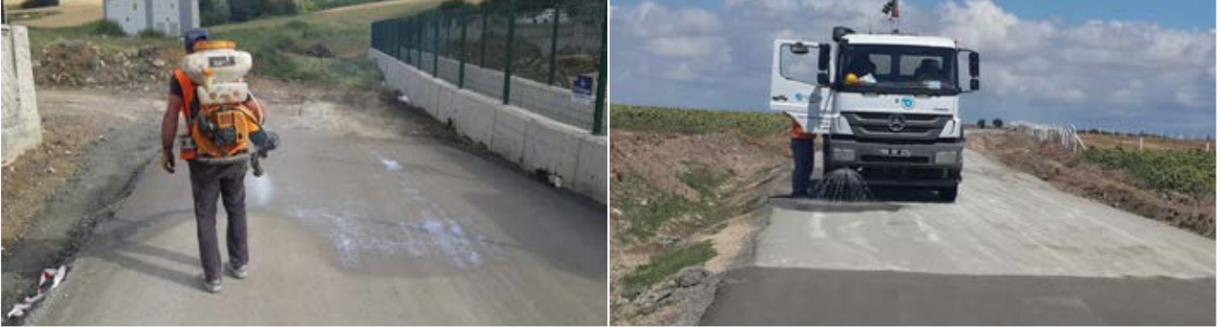
Şekil 10: Betonun kimyasal malzeme (sol) ve su (sağ) ile kürü
