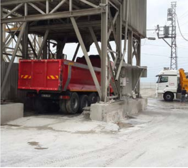
Şekil 2: Damperli kamyonu beton yüklenmesi
