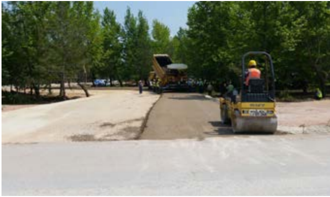
Şekil 4: Bursa Beton AŞ Hazır Beton Tesis girişi SSB yol uygulaması (Haziran 2016)
