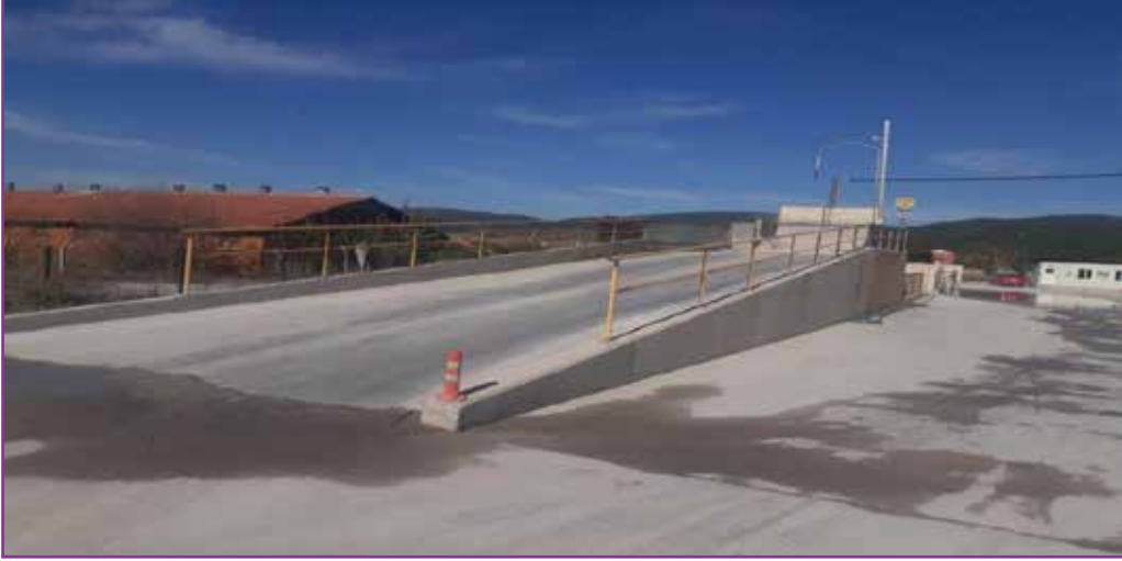
Resim 1: Araç Yıkama Rampası
