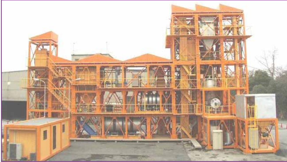
Resim 3: Taşınabilir atık beton geri kazanım tesisi
