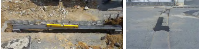
Şekil 9. Beton numunelerin yol uygulaması
