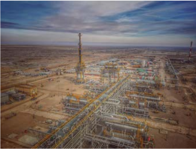
West Qurna 1 Petrol Sahası Petrol İşleme Tesisi, Irak (ENKA)
