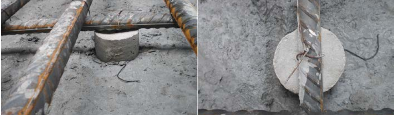
Fotoğraf 5: Beton pas payı elemanının radye temel yapısında kullanımı
