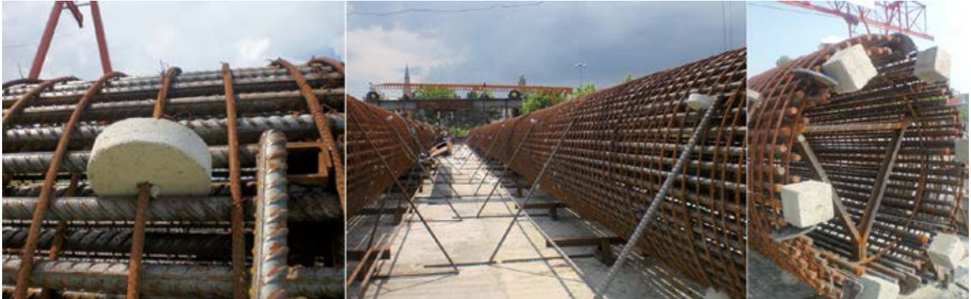
Fotoğraf 7: Beton pas payı elemanının kazık yapılarında kullanımı
