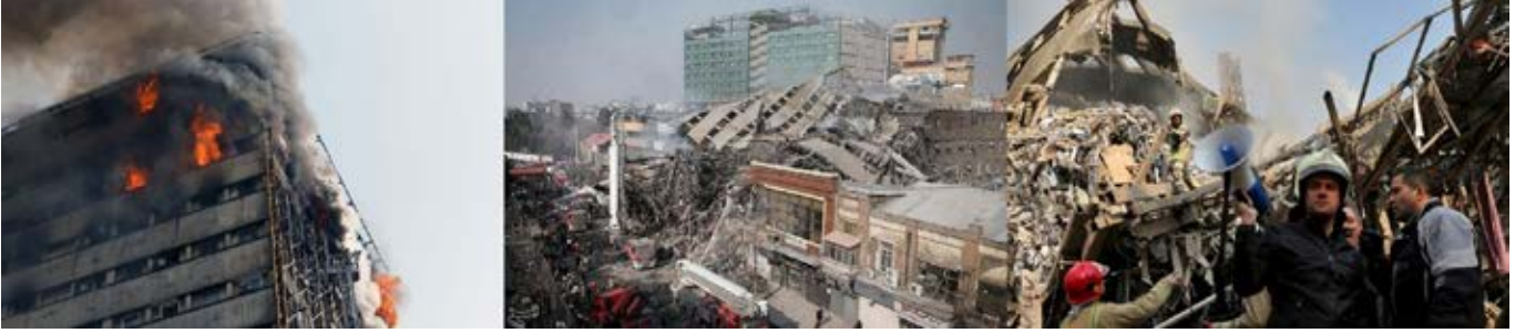
Fotoğraf 2: İran'da yangın esnasında çöken bir bina (2016)
