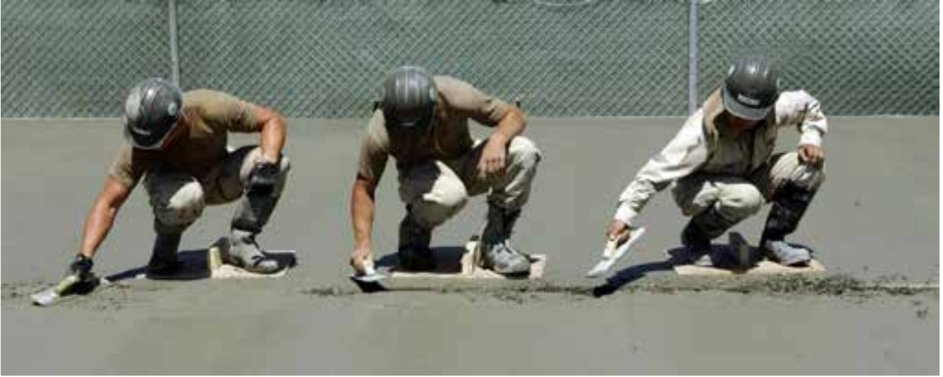
İnşaat işçileri dökülmüş betonu düzeltirken
