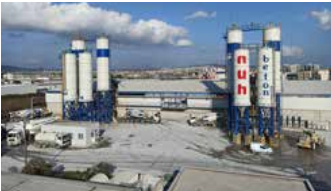
Nuh Beton Kartal Hazır Beton Tesisi
