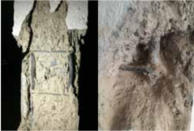
Resim 5: Çapları ve sıklıkları yetersiz, nervürsüz düz donatılar
