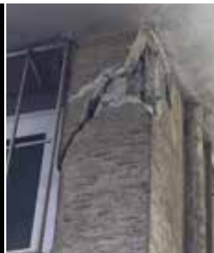
Resim 2: Kısa kolonda kesme hasarı
