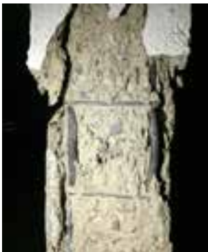
Resim 1: Düşük beton dayanımı ve yetersiz donatıdan dolayı kolonda kesme hasarı
