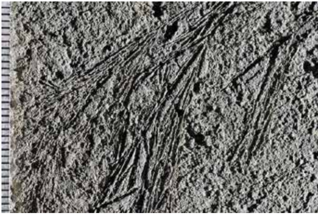
Şekil 1. Donmuş beton içinde bulunan buz kristalleri. Bu numunede, donmadan kaynaklanan hasar sonucu mikro çatlak oluşumu yaklaşık olarak 5 cm derinliğe işlemiştir.. Kaynak: David Rothstein, DRP, A Twining Company
