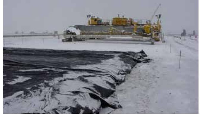
Şekil 4. Betonun ilk ısısını ve hidrasyon ile açığa çıkan ısıyı hapsedmek için yerleştirme işleminden hemen sonra kür kaplamaları kullanmak gereklidir.
