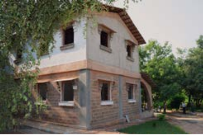
Hindistan'da kireç taşı kalsine edilmiş kil çimentodan yapılmış bir ev. Kaynak: LC3 Project
