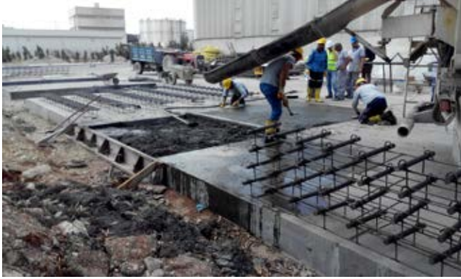
Şekil 6.1. Beton Yol Yapımı
