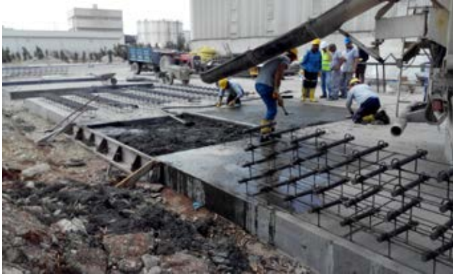
Şekil 6.1. Beton Yol Yapımı
