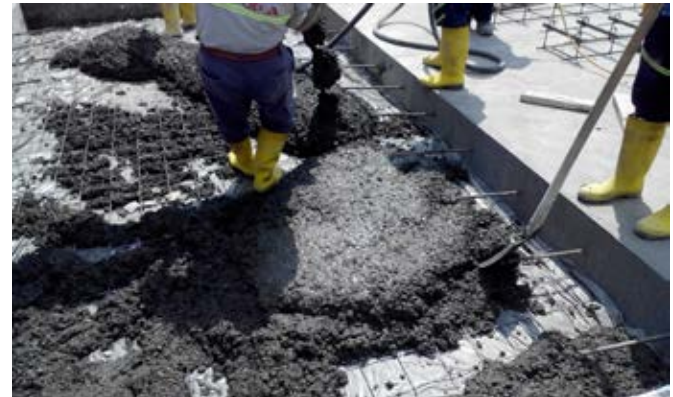
Şekil 6.2. Beton Yol Yapımı
