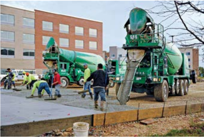
Yeni dökülen beton, işçiler malzemeyi düzleştirip yüzeyini tekstüre ettikçe şekillenir.
