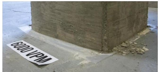
6.000 VPM'nin farklı seviyelerde yüzey boşluklarına nasıl yol açtığını gösteren somut bir örnek.
