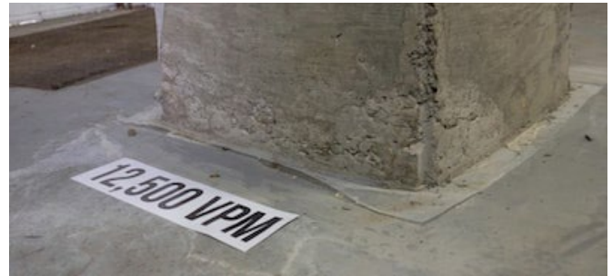
12.500 VPM'nin farklı seviyelerde yüzey boşluklarına nasıl yol açtığını gösteren somut bir örnek.
