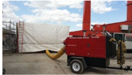
Resim 2: Isıtıcı ile ortam sıcaklığının kontrol edilmesi[7]
