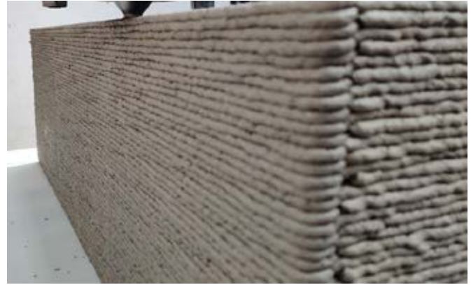
Bir duvar elemanının 3 boyutlu baskı katmanları.
