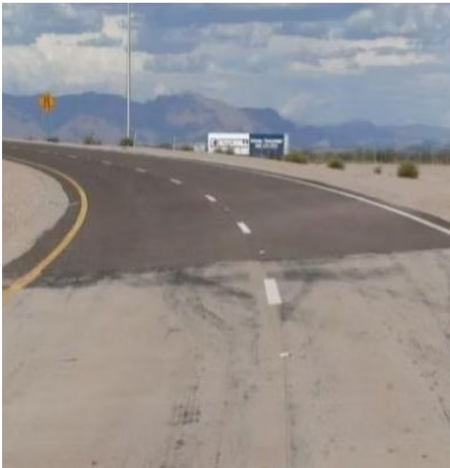
Asfalta geçiş yapan beton yüzeyi gösteren otoyol rampası.
