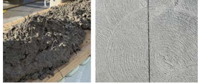
Fiber kullanılan yalıtımlı beton kalıp inşaatı / Tipik fiber takviyeli beton yüzey kaplaması
