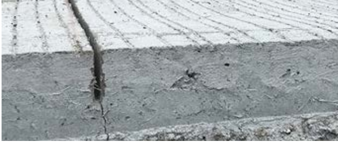
Makro fiber takviyeli beton kaplama
