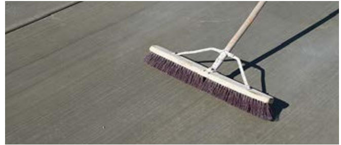
Makrofiber takviyeli beton yüzeyi bitirilişi
