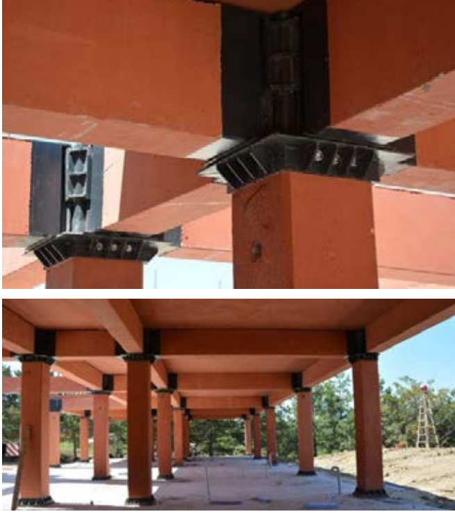
Şekil 3. İYA-esaslı malzemelerin söküp-takılabilen yenilikçi üretim tekniğinde kullanımı
