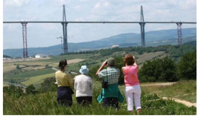
İnşaat çalışmaları neredeyse tamamlandı, Mayıs 2004. Claude Paris / Alamy
