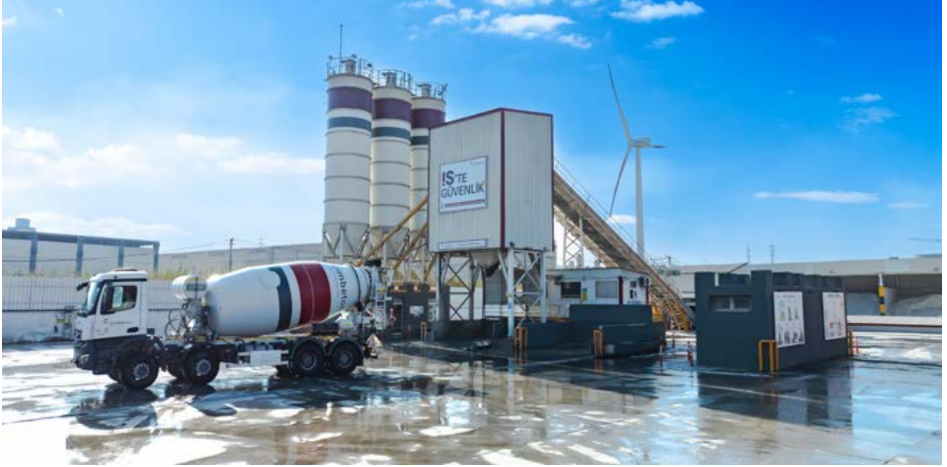
4. THBB Mavi Baret İş Güvenliği Ödülleri Üçüncüsü | Çimbeton Aliağa Hazır Beton Tesisi
