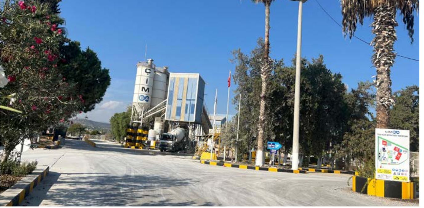
4. THBB Mavi Baret İş Güvenliği Ödülleri İkincisi | Çimsa Tece Hazır Beton Tesisi
