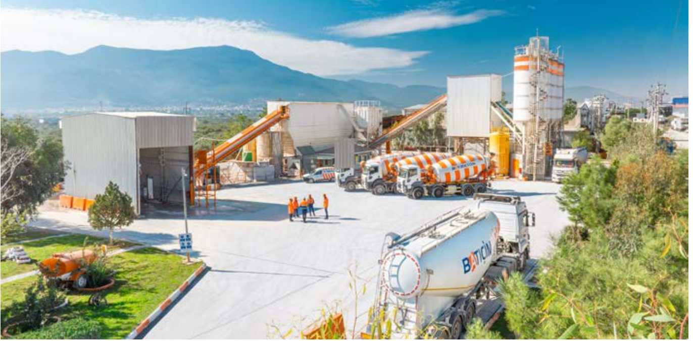
4. THBB Mavi Baret İş Güvenliği Ödülleri Üçüncüsü | Batıbeton Kemalpaşa Hazır Beton Tesisi
