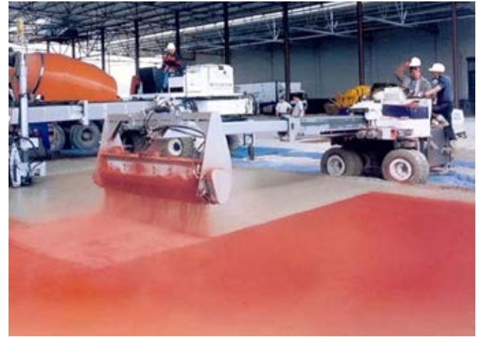
Şekil 2: Zemin betonunun yüzeyine lazer kontrollü olarak serpme türü yüzey sertleştirici uygulanması
