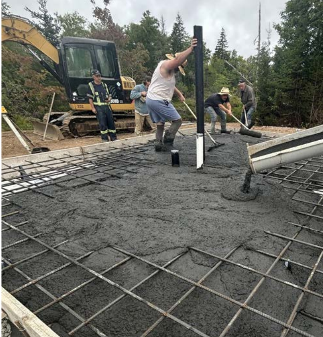
Nova Scotia'daki Casey Concrete şirketi, kısa süre önce AlterBiota biyokömür katkı maddesi ile tasarlanan bir döşeme betonu karışımında çimento optimizasyonunun potansiyelini ortaya koydu.
