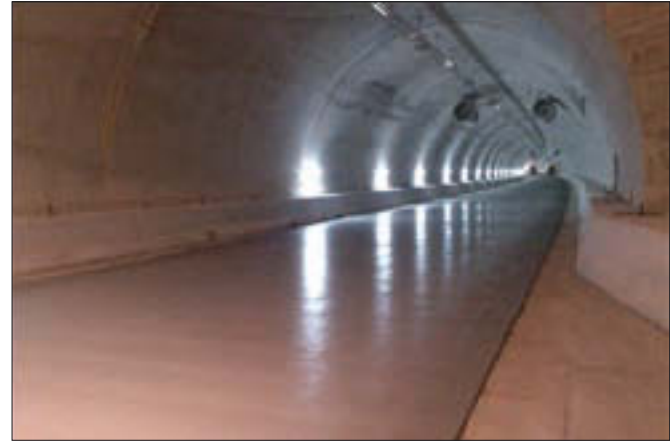
Şekil 5: Maxilotto 1'deki tünellerden birindeki beton yol
